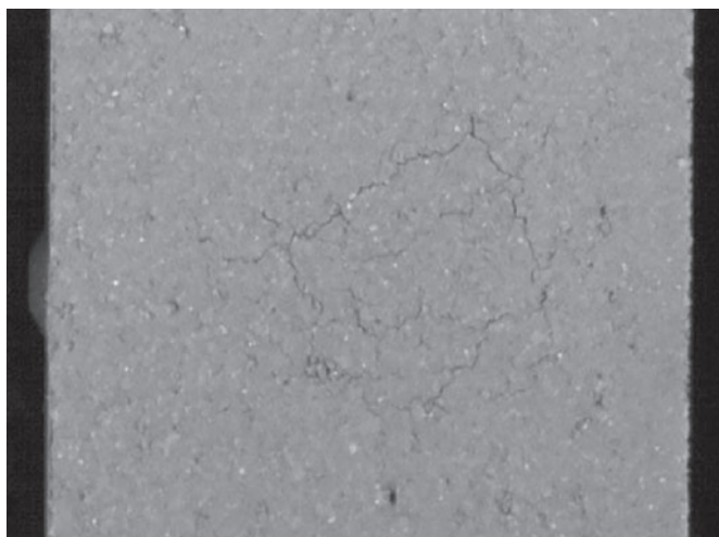
Szczegółowy widok obrazu wykonanego kamerą 2D, pokazujący drobne pęknięcia.
